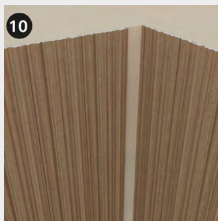
Installare i pannelli sull'altro lato della parete allo stesso modo dei precedenti. Misurare lo spazio rimanente tra il penultimo pannello e l'angolo interno. Tagliare il pannello secondo la misura ottenuta.
